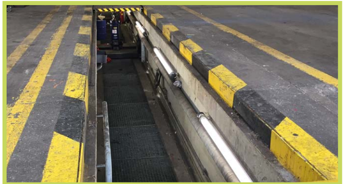
StreamLED 70 - Beleuchtung von Arbeitsgruben
