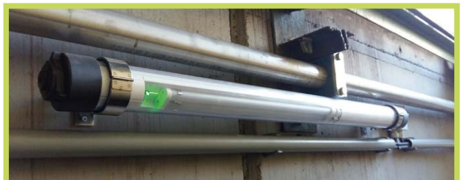
StreamLED 70 Notlicht - Notbeleuchtung eines Energiekanals
