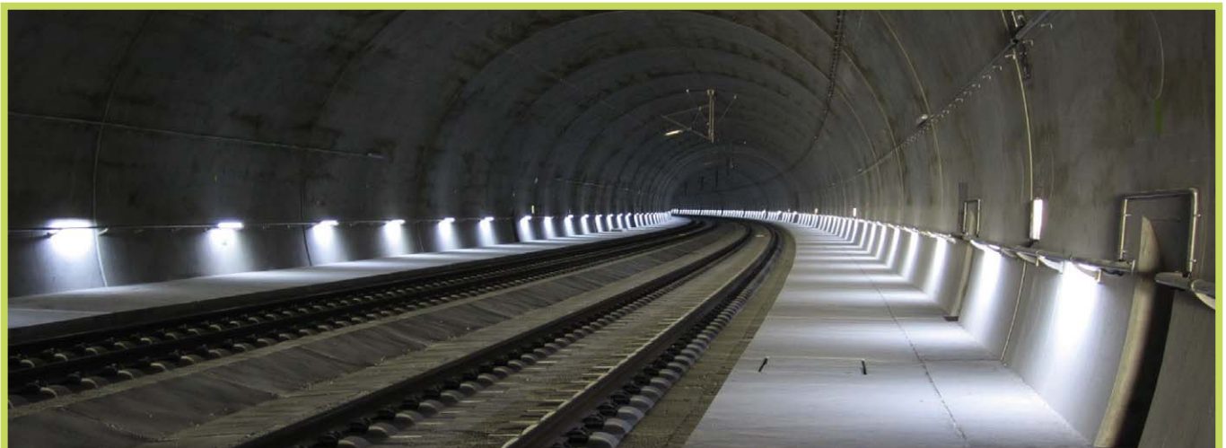
AmbitLED - Beleuchtung Eisenbahntunnel
